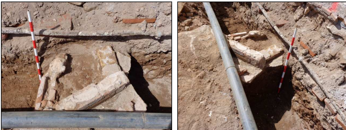
Vista des de l'est i des del nord-est de les clavegueres u.e. 136 i 137.
