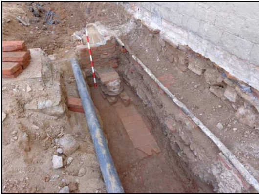
Vista des del nord-est de la claveguera u.e. 141.
