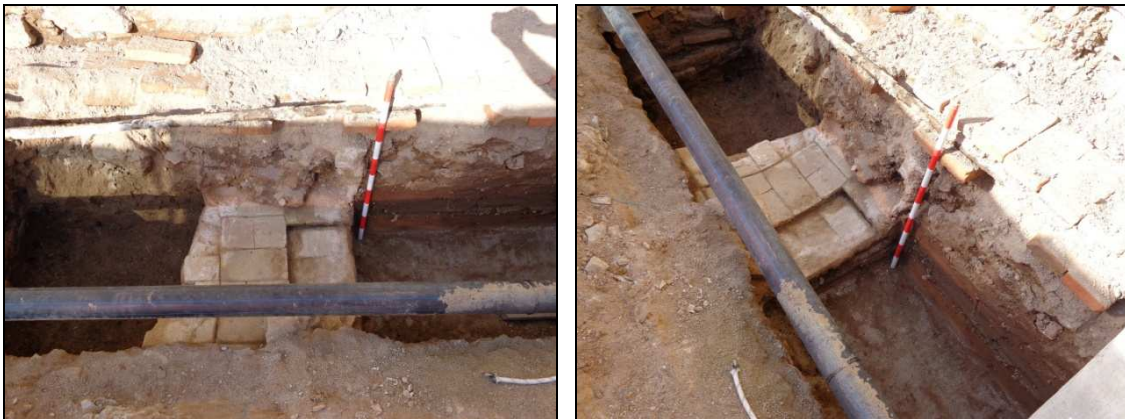
Vista des de l'est i des del nord-est de la claveguera u.e. 121.
