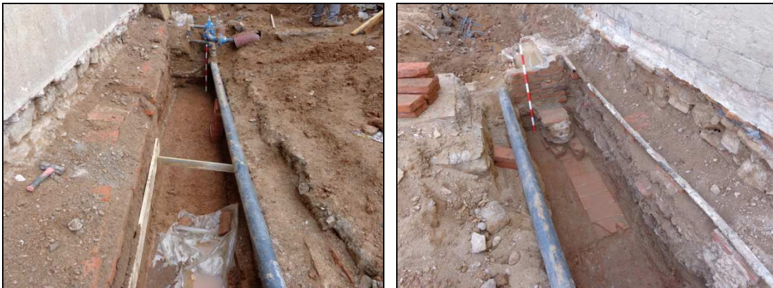
Vista des del sud-est i nord-est dels diferents serveis contemporanis al llarg de la rasa: cable elèctric u.e. 101, canonada de plom u.e. 102, canonada d'aigua de PVC u.e. 103 i col·lector u.e. 172.
