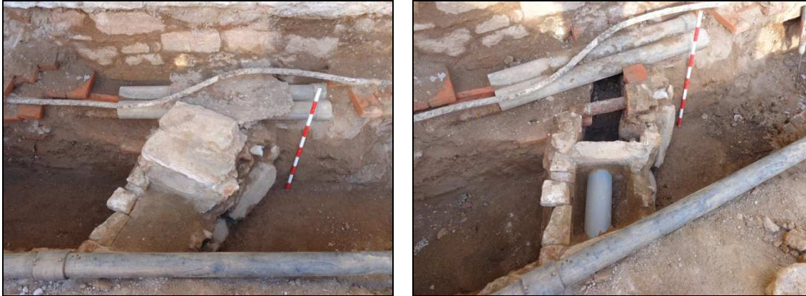
Vista des de l'est de la claveguera u.e. 155 abans i després de la seva excavació, amb la reparació contemporània amb una canonada de PVC u.e. 170.
