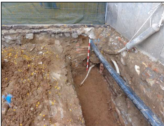
Vista des del nord-est de la claveguera u.e. 166.
