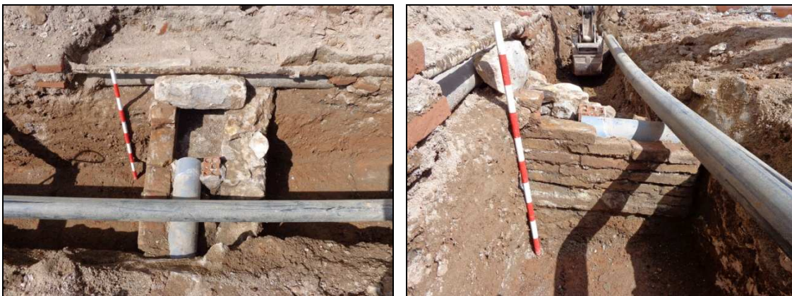
Vista des de l'est i des del sud-est de la claveguera u.e. 135, amb la reparació contemporània amb una canonada de PVC u.e. 134.
