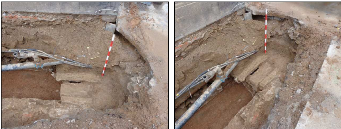
Vista des de l'est i des del sud-est de la claveguera u.e. 116.
