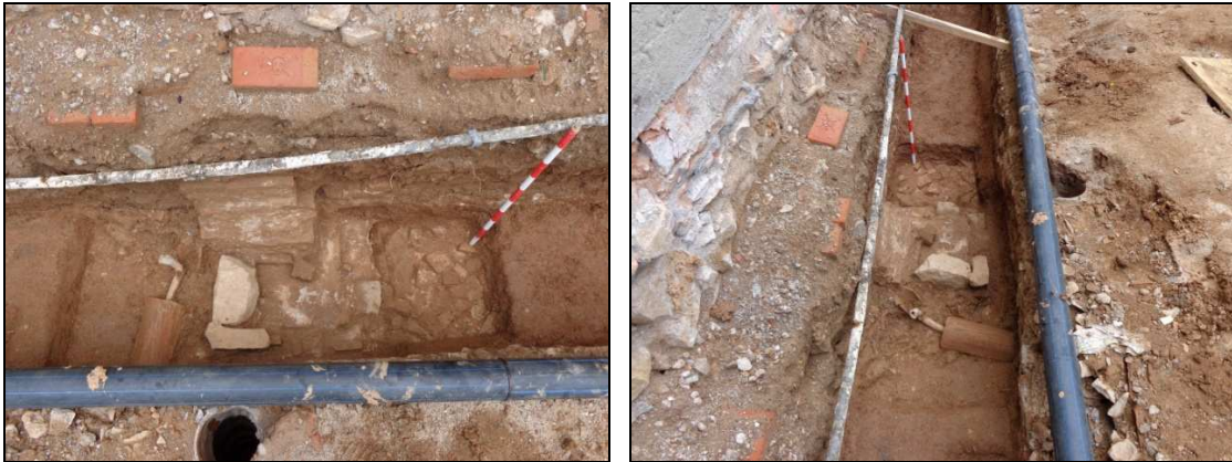
Diverses vistes de trams del mur u.e. 150-157-159, on es pot veure baix com es recolza al parament nord del mur u.e. 139.
