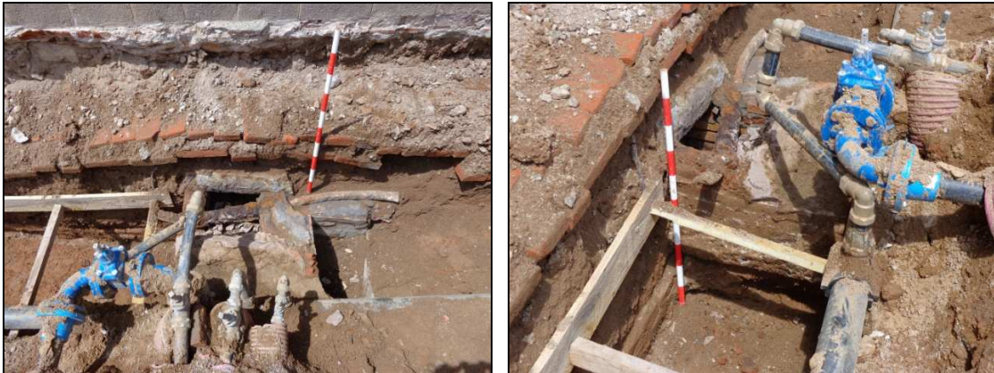
Vista des de l'est i des del sud-est de la claveguera u.e. 104.
